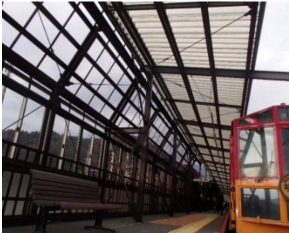
【トロッコ亀岡駅ホーム屋根改良】
