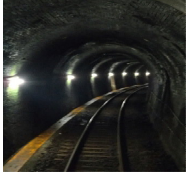
【実施後】(29箇所 LED 化と通路整備)
